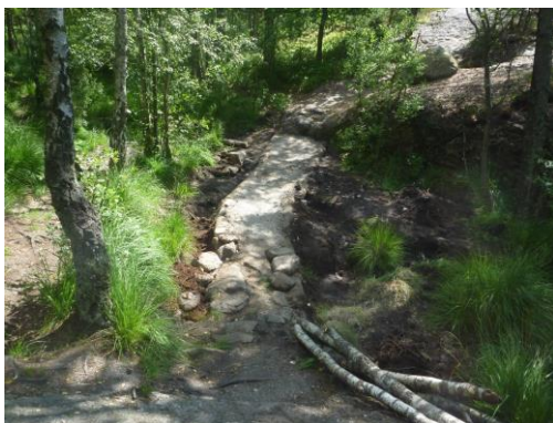
Turnpike uppe på Getryggen under byggnation.
